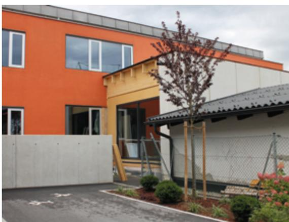
Der neue Essensraum wurde in Holzriegelkonstruktion an der Nordseite des bestehenden Kindergartens angebaut.
